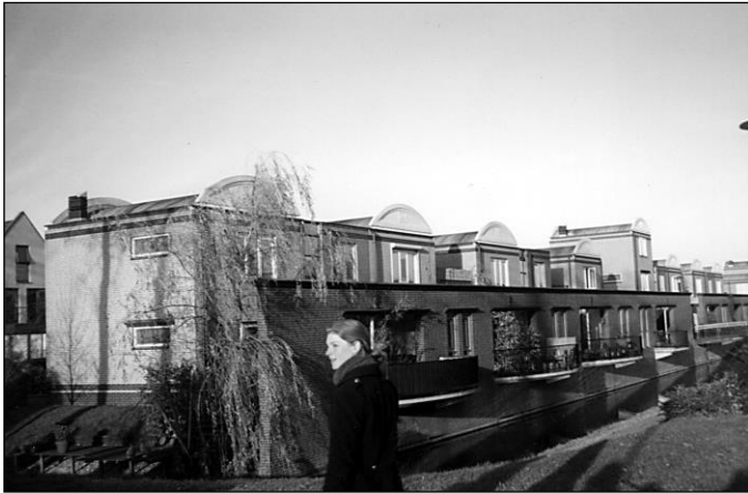
Abbildung 32: Wohnblock an einer Gracht in Kattenbroek
