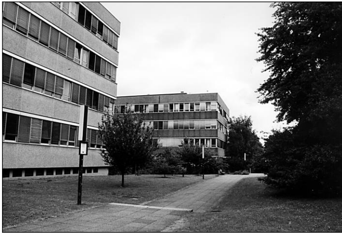
Abbildung 13: Geschossbauten am Campus Süd
